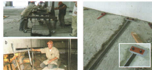
Foto 5. (a) Procedimiento de apertura de la losa en la parte superior para acceder a las vigas de placa. (b) Colocación de una platina de carbono en la parte lateral inferior de una viga.
