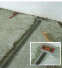
Foto 6. Platina de carbono Sika CarboDur S512 anclada mecánicamente a la viga en la parte superior.
