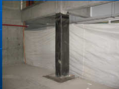
COLUMNAS DEL SOTANO DE SECCION 35X35 BLOQUES 1 Y 2
