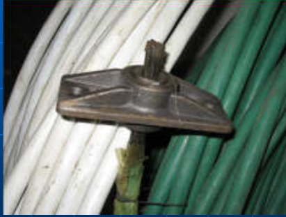
Cables de presfuerzo
