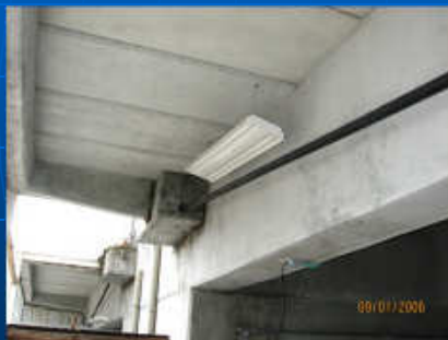
Instalación de ductos y platinas desviadoras
