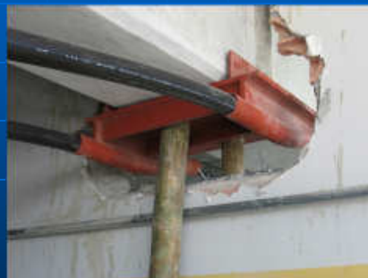
Instalación de ductos y platinas desviadoras
